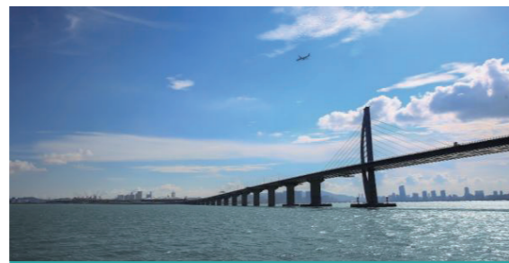
港珠澳大桥工程项目
