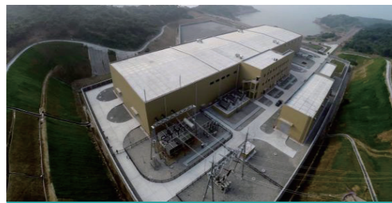
舟山±200kV五端柔性直流输电科技示范工程
