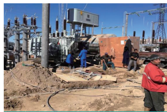
27.5/48kV乌兹别克斯坦铁路工程项目
